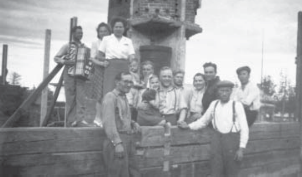
Matkustajakoti Kairan hirsiseinien pystys aloitettiin kesällä 1946 vanhoille perustuksille. Juhannuksena otetussa kuvassa on mukana omistajaperheen jäseniä ja vieraita sekä kirvesmiehiä. Kuva: Irja Hallikaisen kotialbumi.
